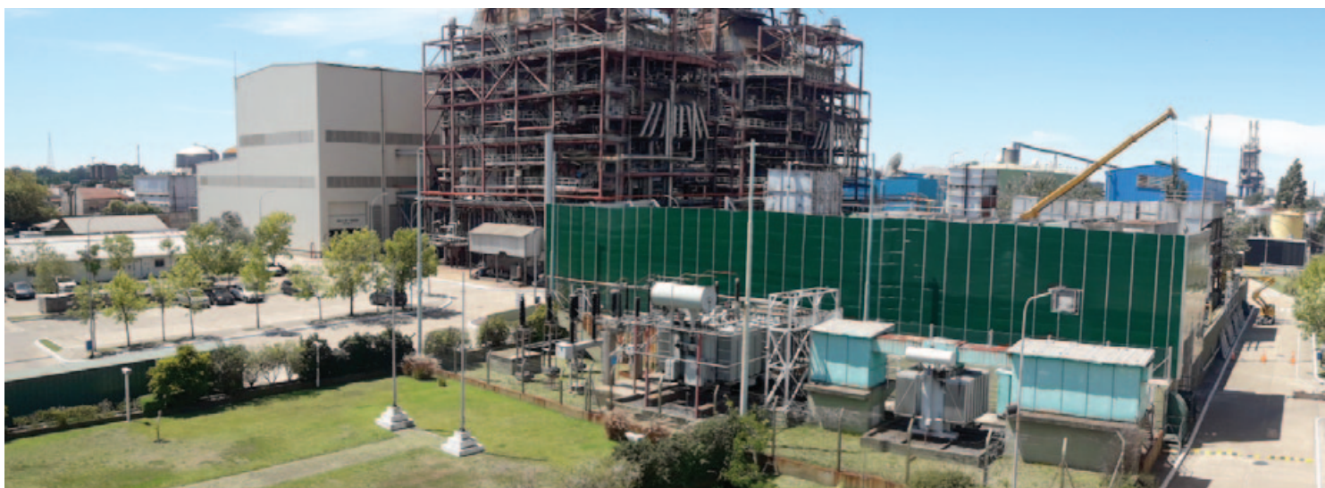
Colocación Central Dock Sud de pantallas acústicas en las terminales generadoras 7 y 8.
